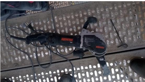
Mittels Stein- und Fugensäge wurde der schadhafte Fugenmörtel präzise und zeitsparend entfernt.
