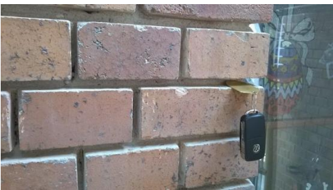
Präzise Arbeit: Die Fugen wurden bis zu sechs Zentimeter tief ausgefräst.
