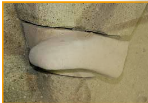
Die Schuhe der Reiter mussten vollständig entfernt und neu gegossen und verankert werden
