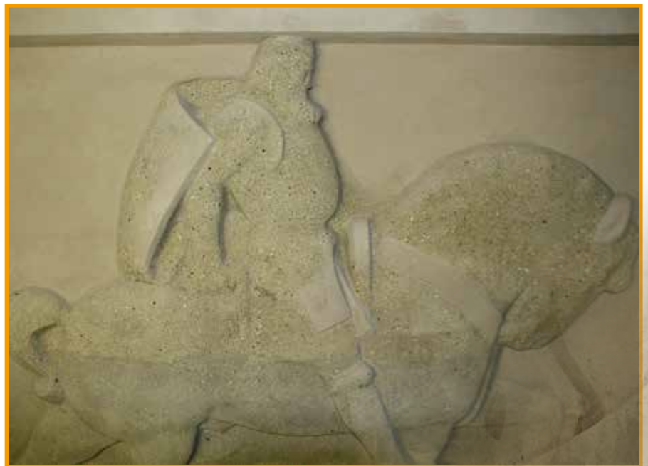
Wieder ein stolzer Reiter: Noch zu erkennen sind die mit Steinrestauriermörtel Rajasil STRM Spezial angetragenen Fehlstellen
