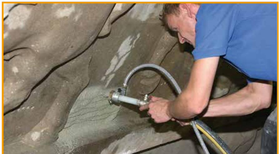
Aufbringen einer Salzkompressen per Maschinenteknik
