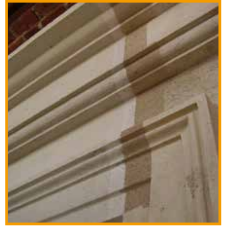
Die Musterachse lässt erahnen wie perfekt das wertvolle Bauwerk nach den Sanierungsarbeiten wieder dastehen wird.
