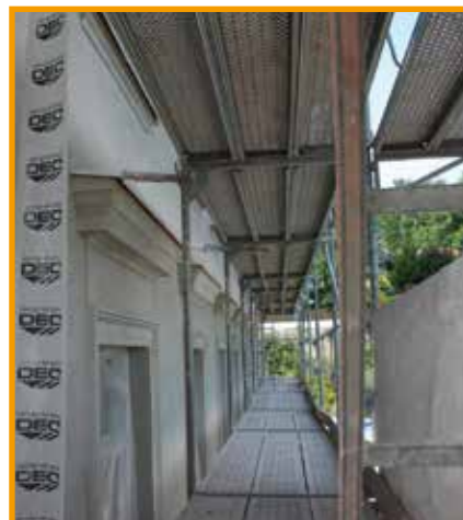
Fenstereinfassungen und -bekrönungen mit Spritzputz Sonderrezeptur, dazwischen ergänzt bzw. erneuert mit Rajasil Trasskalkputz und Gesimsziehmörtel.
