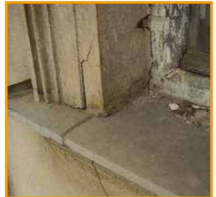
Baudynamische Risse waren typisch für die Bereiche um die Fensterachsen und verteilten sich über die gesamte Fassadenfläche.
