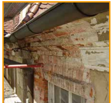
Baudynamische Risse waren typisch für die Bereiche um die Fensterachsen und verteilten sich über die gesamte Fassadenfläche.
