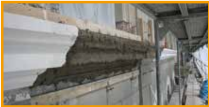
Gurtgesims: Die stark geschädigten Bereiche wurde mit dem Rajasil Sanierputzsystem SP3 erneuert bzw. ergänzt.
