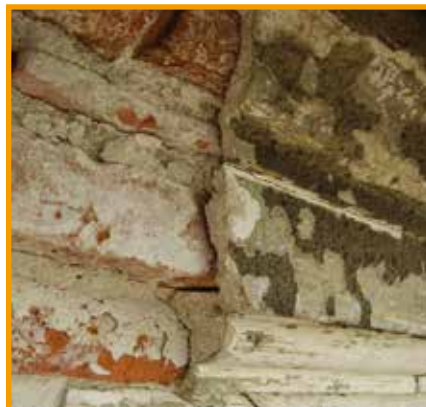
Das Traufgesims konnte in weiten Teilen nicht erhalten werden
