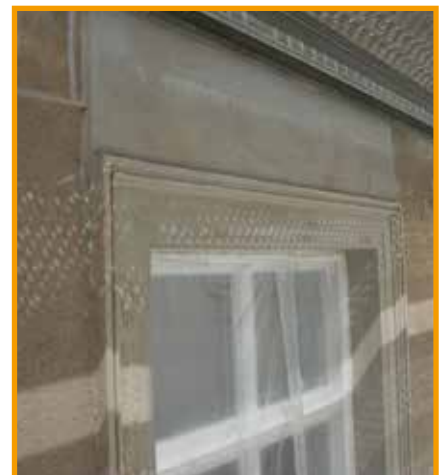
Fenstereinfassungen und -bekrönungen mit Spritzputz Sonderrezeptur, dazwischen ergänzt bzw. erneuert mit Rajasil Trasskalkputz und Gesimsziehmörtel.
