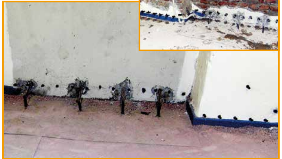
Die Vorbereitungen sind abgeschlossen und das mehrstufige Injektionsverfahren hat begonnen. Bild rechts oben: Erst nach dem Injektionsverfahren wurde der Altputz entfernt.
