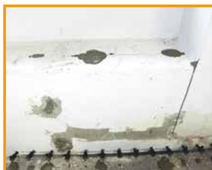
Austretender Injektionsmörtel. Hohlräume im Mauerwerk sind verfüllt.
