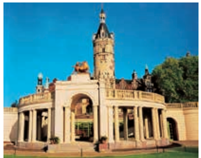
Orangerie (Ansicht von der Seeseite)
