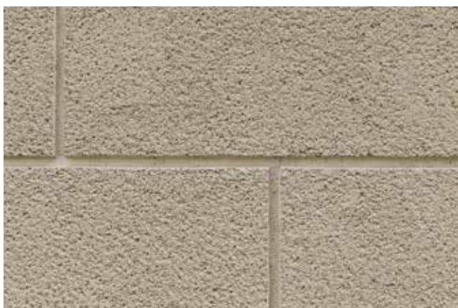
Abb. 10: Nutenputz (Quaderung) (Rajasil Sanierputz 035 zum Kratzen) Kornbereich: 0–3,5 mm Putzdicke: ca. 15 mm Einzelne feine Haarrisse in den Nuten – nur bei Nahansicht erkennbar –, die aber nicht in den Armierungsputz übertragen werden.
