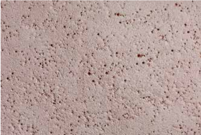
Abb. 14 (oben): Besenstipp (Rajasil EP WD Scheibputz fein) Kornbereich: 0–1,5 mm Putzdicke: 3–4 mm
