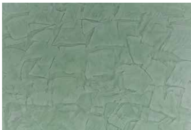
Abb. 13: Spachteltechnik (Rajasil USP Universalspachtel) Kornbereich: 0–0,5 mm Putzdicke: 2–3 mm
