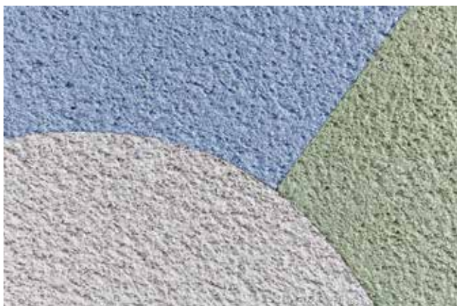
Abb. 4: Intarsien Kratzputz, Detailansicht Der Kratzputz war eine beliebte Oberflächenstruktur, weil durch das Kratzen die bindemittelreichere und daher schwindanfällige Außenschicht abgetragen wurde.
