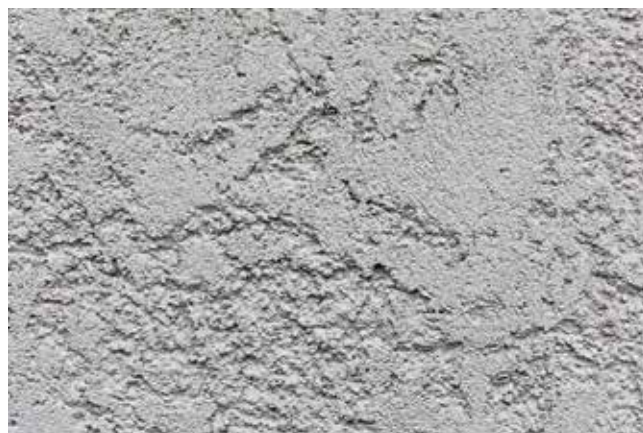
Abb. 5: Nesterputz (Rajasil EP WD Altdeutscher Putz mittel) Kornbereich: 0–3,2 mm Putzdicke: ca. wie Größtkorn
