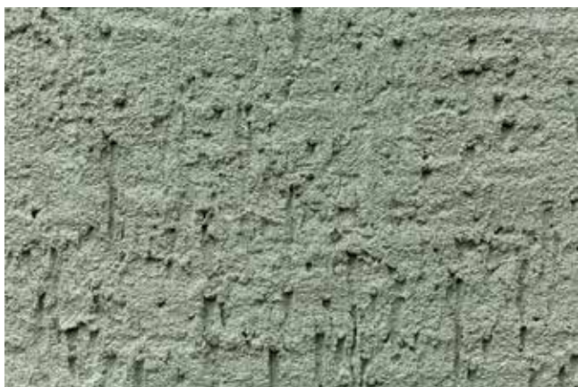
Abb. 8: Ziehputz (Rajasil EP WD Altdeutscher Putz mittel) Kornbereich: 0–3,2 mm Putzdicke: ca. wie Größtkorn
