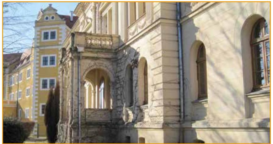
Der italienische Einfluss auf den Baustil ist unverkennbar.
