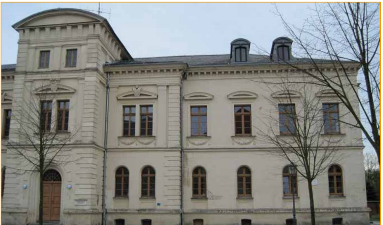
Die reich verzierte Fassade der Grundschule Annaburg ist auch vor der Sanierung gut zu erkennen gewesen.
