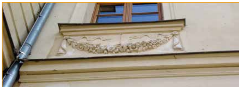
Die Gipsreliefs unter den Fenstern im Obergeschoss sind dank ausreichendem Überstand der Fensterbänke gut erhalten und müssen nicht ersetzt werden.
