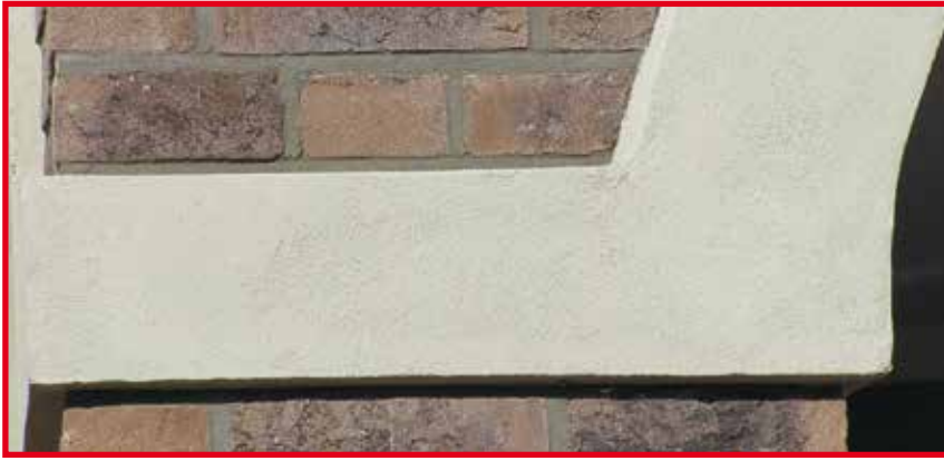
Präzise zugeschnitten und angearbeitet: Teil einer Rundbogenverzierung an den Arkaden.
