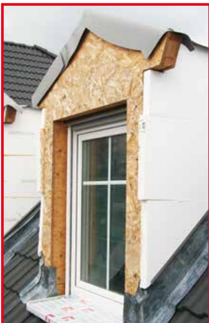
Vorher – Nachher: Die Dachgauben wurden mit großer Sorgfalt gedämmt, um späteren Schäden vorzugreifen
