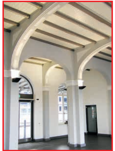
Hier kann man wieder angenehm die Wartezeit verbringen: Die sanierte Empfangshalle mit der wieder freigelegten historischen Holzbalkendecke.
