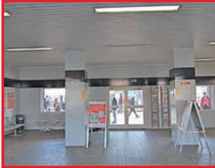
Aufnahme der Wartehalle mit noch abgehängter Decke vor der Sanierung.
