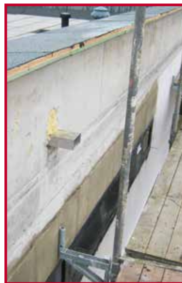
Anbringen des neuartigen WDV-Systems.
