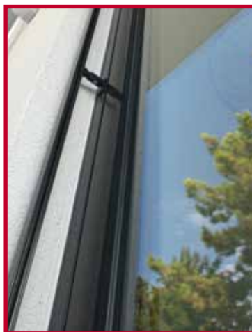
Das neue WDV-System HECK AERO hat es möglich gemacht: Dank der extrem dünnen Dämmplatten schließen Fassade und Jalousie perfekt ab.
