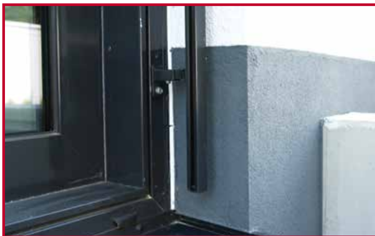
Bereich mit Standard-Dämmsystem: Auch die Anschlüsse an den Fenstern und Fensterbänken wurden perfekt herausgearbeitet und angepasst.
