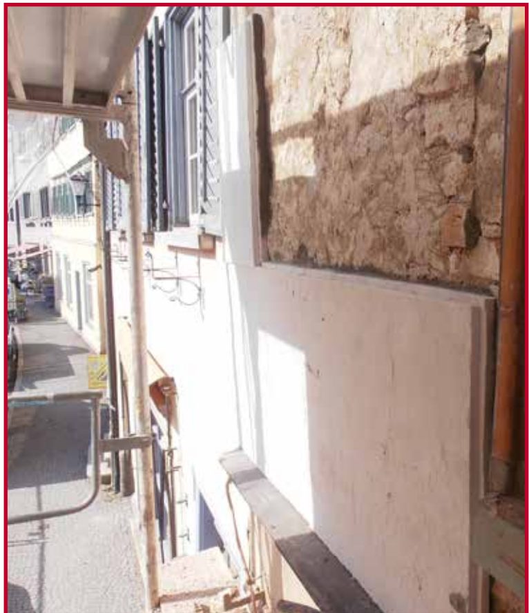
Die Hightech-Dämmplatten folgen den vorgegebenen Verformungen des Bauwerks und schmiegen sich an die grobe Struktur des verputzten Mauerwerks. Gut zu erkennen ist auch die Verarbeitung in Stufenfalz-Technik.
