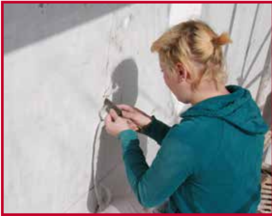
Wärmebrückenfreie Verarbeitung: Zur Vermeidung von Wärmebrücken ist das Ausfüllen von eventuell entstehenden Plattenfugen mit gleichem Dämmmaterial besonders wichtig. Im Bild eine Mitarbeiterin der Fa. Frank Mauer (Wangen) bei der Arbeit.
