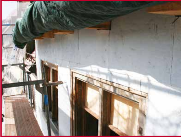
Anschluss des Dämmsystems an bestehende historische Fenster.
