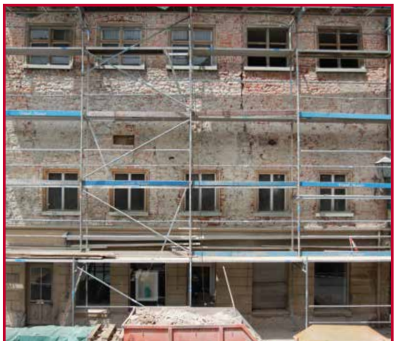
Der Herstellung eines tragfähigen Untergrundes kommt bei der Sanierung von historischen Gebäuden eine erhöhte Bedeutung zu. Hier wurde der Zementputz der 1930er Jahre vollständig entfernt.
