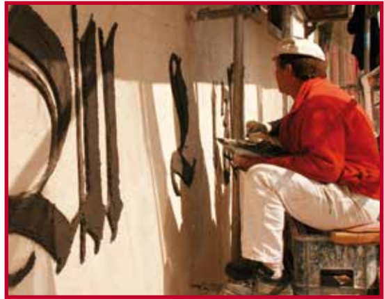
Echte Handwerkskunst und professionelle Produkte gingen bei der Sanierung des historisch wertvollen Baudenkmals in Wangen Hand in Hand. Im Bild wird mit Rajasil KP (Kalkputz) der Gebäudeschriftzug originalgetreu wiederhergestellt.
