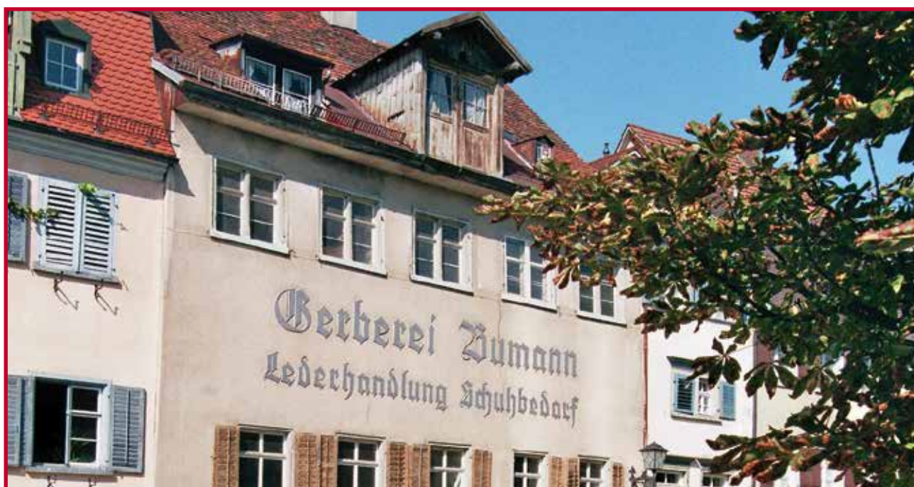
Die Alte Kanzlei vor der Sanierung. Die Frontansicht lässt den bevorstehenden Sanierungsaufwand nur erahnen.
