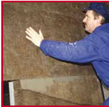
Ankleben der Lamellen-Dämmplatten auf die Betonfertigteilelemente.
