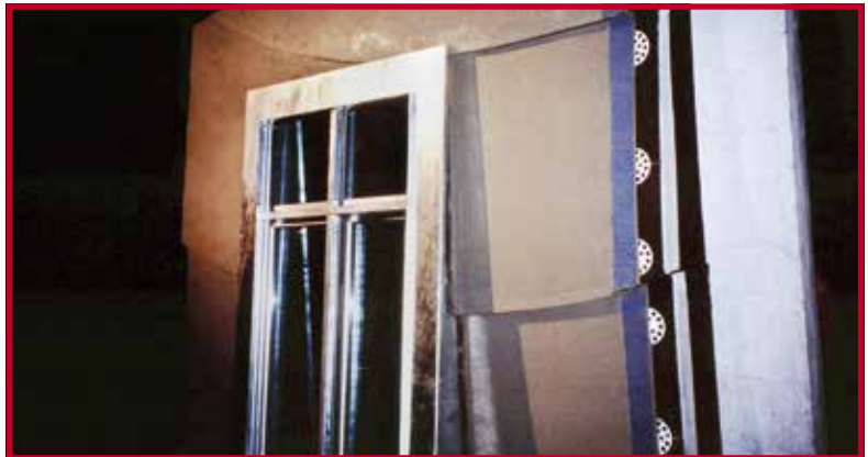
Anhand eines Modells in Originalgröße überzeugte sich Frank O. Gehry vor Beginn der Arbeiten noch einmal von der Machbarkeit des Projektes. Der Systemaufbau: Betonfertigteilelement, Dämmplatten HECK MW-Lamelle 040 sowie HECK MW-Dämmplatte 040, Verdübelung, Grundputz mit Armierungsgittergewebe, Oberputz.
