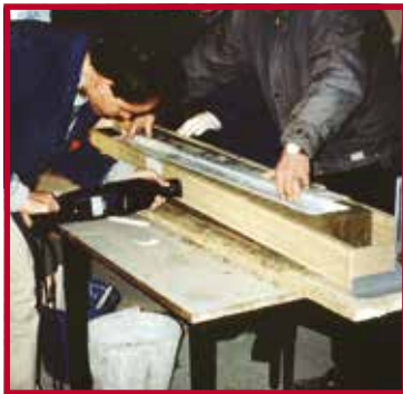
Zuschnitt der Lamellen-Dämmplatten mit einem speziell angefertigten Holzgestell. Ein eigens entwickeltes Computerprogramm errechnete zuvor die entsprechenden Neigungswinkel.
