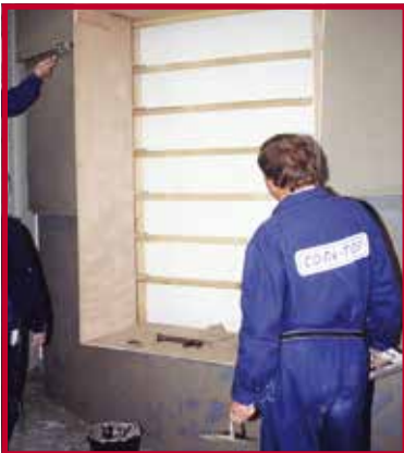
Verarbeiter-Schulung in Marktredwitz, um die tschechischen Kollegen fit zu machen für die Prager Baustelle.
