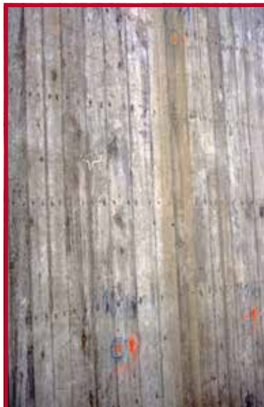
Die Koordinaten, die den Verlauf der Wellenlinien vorgeben, wurden mittels Lasertechnik auf die Fassade projiziert.
