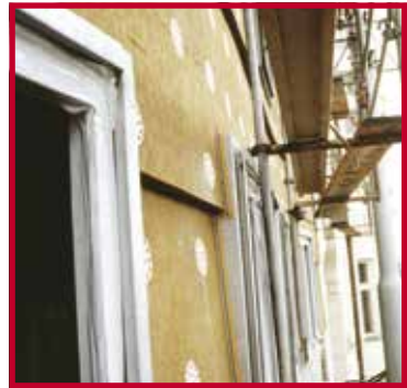
Die Gebäudehöhe erforderte eine zusätzliche Verdübelung der Mineralwolle-Dämmplatten.
