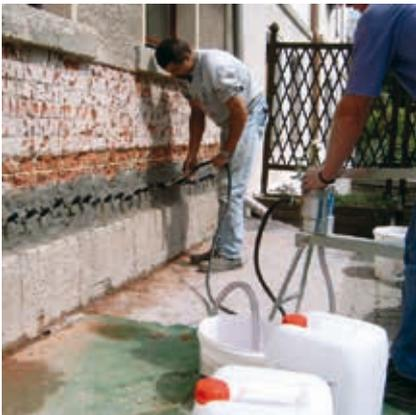
Nach 1 bis 2 Tagen erfolgt eine Injektion mit Rajasil BLF (Bohrlochflüssigkeit) (Abläufer mit Wasser entfernen).
