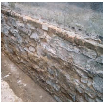
Der Altputz wird nach dem Aufschichten im erdberührten Bereich komplett entfernt und das Mauerwerk von Staub und losen Teilen gereinigt. Mürbe Fugen werden ca. 2 cm tief ausgekratzt.
