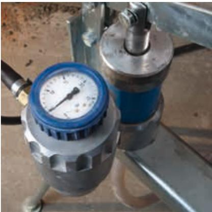
Der erforderliche Injektionsdruck von 3 – 5 bar wird über einen Zeitraum von ca. 10 Minuten (in Abhängigkeit von den Mauerwerksbedingungen) gehalten.
