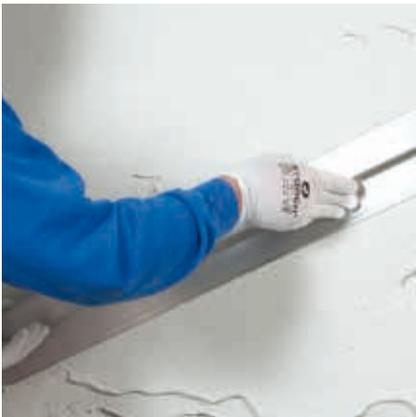
Nach einer Standzeit von ca. 4 Tagen wird der Oberputz in einer Mindestdicke von 20 mm aufgetragen. Die Oberfläche wird während des AnstEIFENS lot- und fluchtrecht bzw. dem Mauerwerk folgend abgezogen und kann anschließend z.B. durch Filzen strukturiert werden (Anstrichsysteme auf Sanierputz siehe 3.6).
