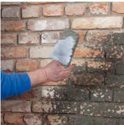
Bei wenig saugenden, glatten Untergründen wird Rajasil SPB (Spritzbewurf) netzförmig als Haftbrücke aufgebracht (Standzeit mindestens 12 Stunden). Der Rajasil SPB (Spritzbewurf) darf den Untergrund nur zu 50 % bedecken. Der Auftrag kann mit geeigneter Putzmaschine oder von Hand erfolgen.
