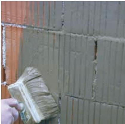
Auf gut saugenden, tragfähigen Putzgründen (z. B. Ziegel- und Kalksandsteinmauerwerke) wird Rajasil LS (Lehmschlämme) aufgebracht. Stark saugende Untergründe vor Schlämmauftrag gut vornässen. Der Putzgrund wird ein- bis zweimal mit Rajasil LS (Lehmschlämme) satt vorgestrichen.
