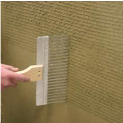
Bei Putzdicken über 20 mm wird mehrlagig gearbeitet. Bei dieser Vorgehensweise wird die jeweils untere Lage sorgfältig aufgeraut (z. B. mit einem neuen Straßenbesen oder mit einem Putzkamm).
