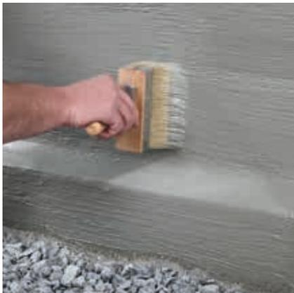
Die schnell erhärtende Dichtungsschlämme sorgt für die zuverlässige Abdichtung und macht eine zusätzliche Haftbrücke für den Dämmputz unnötig.
