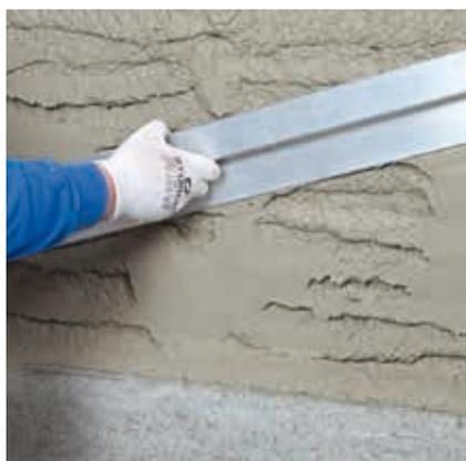
Auf den vorbereiteten Untergrund wird Rajasil SPB (Spritzbewurf) volldeckend als Haftbrücke aufgebracht. Nach einer Standzeit von ca. 4 Tagen erfolgt der Auftrag von Rajasil SPP (Sperrputz) in einer Dicke von 1,0 bis 1,5 cm je Lage (von Hand oder mit der Putzmaschine). Die einzelnen Lagen werden gut aufgeraut. Die Oberfläche wird dem Mauerwerk folgend abgezogen. Vorher werden Vertiefungen und Unebenheiten mit Rajasil SPP (Sperrputz) egalisiert.
