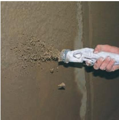
Rajasil KP (Kalkputz) bzw. Rajasil TKP (Trasskalkputz) wird in einem ersten Arbeitsgang aufgebracht. Beginnt diese Schicht anzusteißen, so wird nass-in-feucht eine weitere Schicht Mörtel angeworfen, bis die vorgesehene Unterputzdicke erreicht ist. Der Auftrag kann mit geeigneter Putzmaschine oder von Hand erfolgen.
