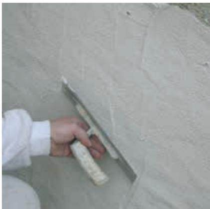
Saugendes Mauerwerk wird vorgehässt. Auf den mattfeuchten Untergrund wird Rajasil SSL (Sanierschlämme) in einer Mindestdicke von 8 mm mit der Traufel so angetragen, dass die vorhandenen Mauerwerksfugen noch erkennbar sind. Wird die Rajasil SSL (Sanierschlämme) mit der Putzmaschine (mit geeignetem Nachmischer) aufgetragen, soll sich das Fugenbild abzeichnen.
