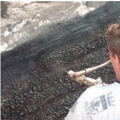
Die Verarbeitung von Rajasil DB (Dickbeschichtung) bzw. Rajasil 2K DB (2 K-Dickbeschichtung) kann von Hand oder maschinell erfolgen. Der Auftrag muss fehlerstellenfrei, gleichmäßig und in der Dicke je nach Lastfall erfolgen. Bei Arbeitsunterbrechungen muss die Bitumendickbeschichtung auf Null ausgestrichen werden (bei Wiederaufnahme der Arbeiten überlappend weiterarbeiten). Arbeitsunterbrechungen dürfen nicht an Gebäudeecken erfolgen.
