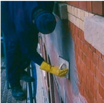
Rajasil FM SLF (Fugenmörtel schlämmfähig) kann frühestens 24 Stunden nach der Vorimprägnierung aufgebracht werden und wird mit einem Hartgummi-schwambrett gut verdichtend im „Kreuzschlag“ in die Fugen eingeschlämmt.
