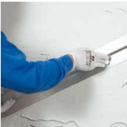
Die zweite Lage Rajasil SP3 (Sanierputz SP3) bzw. Rajasil SP4 (Sanierputz SP4 mit HyTer-Technologie) wird in einer Dicke von 10-15 mm auf die an der Oberfläche gleichmäßig trockene erste Lage aufgebracht (Gesamtsanierputzdicke mindestens 20 mm).
