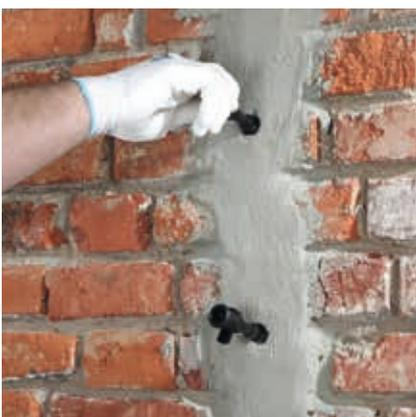
Der Bohrlochdurchmesser für Rajasil Lamellenschlagpacker beträgt 18 mm. Die Bohrlöcher werden z. B. durch Ausblasen und anschließendem Ausspülen gründlich gereinigt. Die Lamellenschlagpacker werden mit Hilfe eines Einschlagdöppers gesetzt und mit Rajasil Verschlussstücken versehen. Alle Verschlussstücke sind bei Beginn der Injektion geöffnet.
