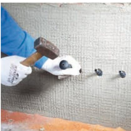
Rajasil Lamellenschlagpacker werden mit Hilfe eines Einschlagdöppers gesetzt und mit Rajasil Verschlussstücken versehen.
