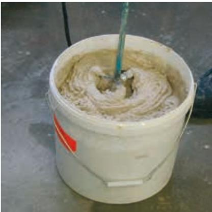
Unter Vorgabe der notwendigen Wassermenge wird der Mörtel in einem sauberen Mörtelkübel per Hand oder mit dem Motorquirl knollenfrei angemischt. Die notwendige Anmachwassermenge richtet sich nach der Saugfähigkeit des Steins, nach der Witterung und der gewünschten Konsistenz (von erdfeucht bis plastisch). Für dünn-schichtige Ergänzungen in der Schlammtechnik wird das Material pastös eingestellt.
