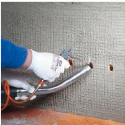
Die Bohrlöcher werden anschließend z. B. durch Ausblasen (z. B. mit Druckluft), Aussaugen oder Auskratzen gründlich gereinigt.
