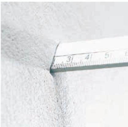
Die Mindestsanierputzdicke beträgt 20 mm und die maximale Gesamtsanierputzdicke 40 mm.
