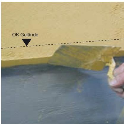
Der Sanierputz sollte wenig in das Gelände einbinden (ca. 10 cm). Der Putzabschluss im erdberührten Bereich wird mit einer Abschrägung (abgerundete Kanten ohne Grate) ausgeführt.
