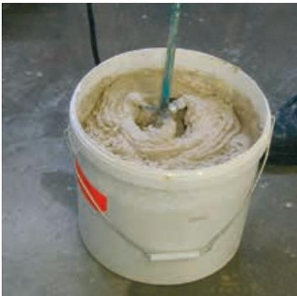
Unter Vorgabe der notwendigen Wassermenge wird der Mörtel in einem sauberen Mörtelkübel per Hand oder mit dem Motorquirl knollenfrei angemischt. Die notwendige Anmachwassermenge richtet sich nach der Saugfähigkeit des Steins, nach der Witterung und der gewünschten Konsistenz (von erdfeucht bis plastisch). Es muss so viel Wasser zugegeben werden, dass der Mörtel formbar ist und nach dem Anbringen ohne Schalung stehen bleibt.
