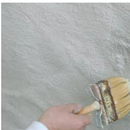
Im Laufe der Erhärtung kann die Oberfläche z. B. mit der Malerbürste überarbeitet werden, um die gewünschte Schlämmputzstruktur zu erzielen.
