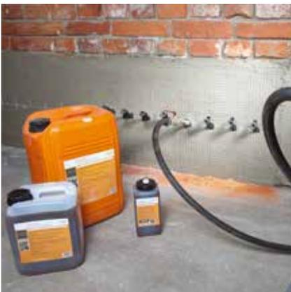
Über die angebrachten Packer wird Rajasil BLF (Bohrlochflüssigkeit) oder Rajasil NIG mittels Handhebelpresse oder einer elektrisch betriebenen Injektionspumpe eingebracht.
