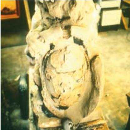
Die schadhafte Schicht wird bis auf den gesunden Naturwerkstein entfernt. Glatte Oberflächen werden mit einem Spitz- oder Zahneisen aufgeraut.
