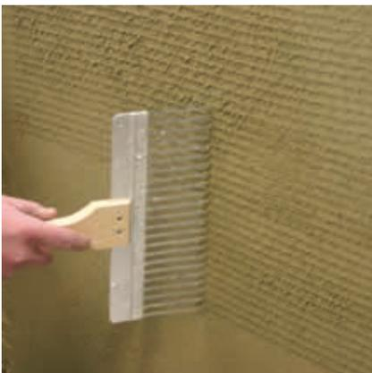
Für dünn-schichtige, mineralische Oberputze wird die Putzoberfläche unmittelbar nach dem Putzauftrag abgezogen und rabotiert bzw. für dickschichtige Oberputze abgezogen und aufgeraut (siehe 3.6).
