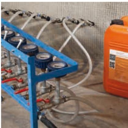
Ein rationelles Arbeiten wird durch den Einsatz einer Verteilergalerie erreicht. Dabei muss die Injektion jedes einzelnen Bohrlochs kontrolliert erfolgen. Eine Überwachung des Druckes (Manometer) sollte gegeben sein.
