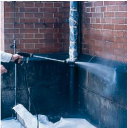
Die verschmutzte Fassade wird möglichst schonend gereinigt. Die Fassade muss nach einer Nassreinigung vor dem Imprägniermittelauftrag austrocknen.
