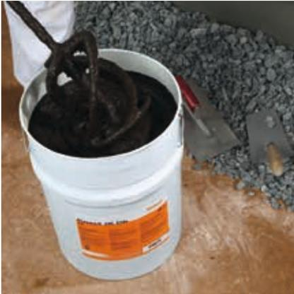
Bei Rajasil 2K DB (2K-Dickbeschichtung) wird die Emulsion kurz durchgerührt, die Pulver-komponente zugegeben und mit schnell laufendem Rührgerät intensiv gemischt, bis eine homogene, knollenfreie Masse entsteht.
