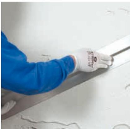
Der schnell erhärtende, saugfähige Dämmputz ist wärmedämmend, kapillaraktiv, feuchtepuffernd und sorgt für eine optisch saubere Oberfläche. Durch die weiße Farbe ist kein zusätzlicher Anstrich notwendig.
