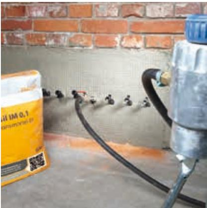
Über die angebrachten Packer wird Rajasil IM 0,1 (Injektionsmörtel 01) mittels Handhebelpresse oder einer elektrisch betriebenen Injektionspumpe mit einem Druck von ca. 5 bar injiziert.
