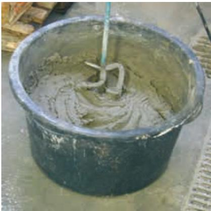
Trockenmörtel mit reinem Wasser in einem sauberen Gefäß mit dem Motorquirl angemacht (Mischzeit ca. 2 Minuten). Angeteigte Masse 5 - 10 Minuten reifen lassen und nochmals durchmischen.
