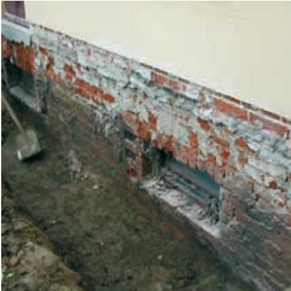
Der Altputz wird nach dem Aufschichten im erdberührten Bereich komplett entfernt und das Mauerwerk von Staub und losen Teilen gereinigt. Mürbe Fugen werden ca. 2 cm tief ausgekratzt. Der Untergrund muss frei von haftungsstörenden Schichten (z. B. Schalöl, Teer, Schmutz, alte Beschichtungen) sein.
