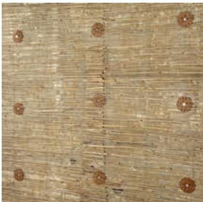
Bei nicht tragfähigem Untergrund wird anstelle der Rajasil LS (Lehmschlämme) ein Putzträger, z. B. Schilfrohmatten oder Ziegeldrahtgewebe aufgebracht. Der Putzträger wird mit geeigneten, korrosionsbeständigen Dübeln (z. B. HECK Schlagdübel NK-U mit HECK Dübelteller 60) befestigt.
