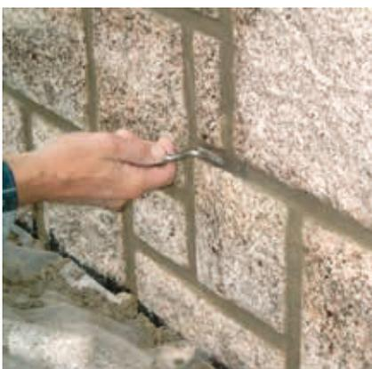
Der Fugenglattstrich kann mit Fugholz, Fugeisen oder einem Schlauchstück erfolgen. Je nach Material und Rauigkeit des Werkzeugs entsteht eine raue und damit dunkler wirkende oder eine glatte, helle Fugenoberfläche.
