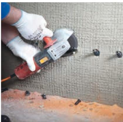
Nach der Injektion werden die Verschlussstücke abgeschraubt und gereinigt (sie können wieder verwendet werden).
