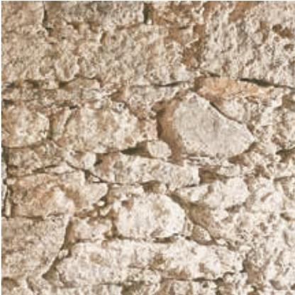
Nach dem Entfernen des Altputzes werden mürbe Fugen ca. 2 cm tief ausgekratzt. Das Mauerwerk sowie die Fugen werden gründlich von Staub, losen Teilen und Trennschichten befreit.
