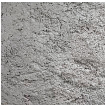
Bei mit Dichtungsschlämme verdämmtem Mauerwerk wird Rajasil DS FLEX (Dichtungsschlämme flexibel) nochmals satt aufgetragen und anschließend Rajasil SPP (Spritzbewurf) netzförmig in die noch frische Schlämme eingeworfen.
