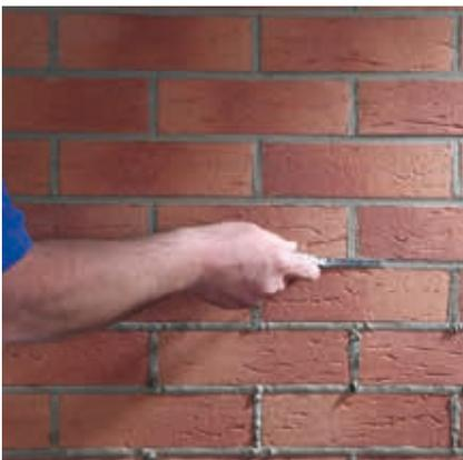
Auch eine maschinelle Verfugung mit Schneckenpumpe und Verfugpistole ist möglich.
