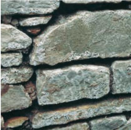
Die Fugen werden von losem und mürbem Fugenmaterial gründlich gesäubert und so vorbereitet, dass der einzubringende Fugenmörtel eine mittlere Dicke von mindestens 2 cm aufweist (die Fugentiefe sollte ca. der doppelten Fugenbreite entsprechen).
