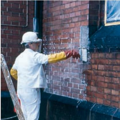
Loser und mürber Fugenmörtel wird bis auf eine Tiefe von mindestens 6 mm entfernt. Die Fugen werden von Staub und losen Teilen gründlich gereinigt.
