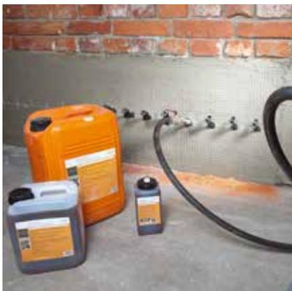
Die Wirkstoffinjektion mit Rajasil NIG erfolgt in den angesteiften, noch nicht abgebundenen Mörtel. Der erforderliche Injektionsdruck von 3 – 5 bar ist über einen Zeitraum von 5 – 10 Minuten (in Abhängigkeit von den Mauerwerksbedingungen zu halten). Anschließend wird das Verschlussstück geschlossen.
