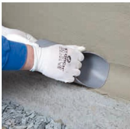
Innenecken und Wand-/Bodenanschlüsse werden als Hohlkehle ausgebildet und mit Rajasil SPP (Sperrputz) mit einem Radius von ca. 5 cm (Flaschenhohlkehle) hergestellt. Nicht gefaste Außenecken und Fundamentkanten sind zu brechen (anfassen).
