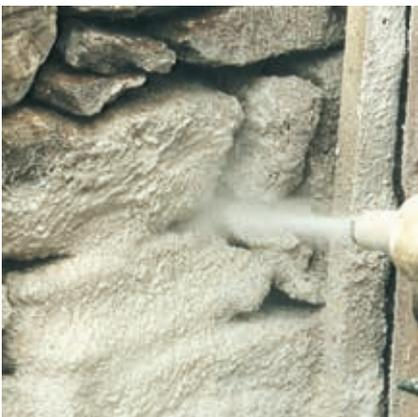
Rajasil SM VARIO (Spritzmörtel Vario) ist besonders für pneumatische Förderung im Trockenspritzverfahren geeignet und mit handelsüblichen Trockenspritzmaschinen zu verarbeiten.
