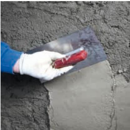
Der vorhandene Altputz wird erst nach dem Einbringen der Horizontalabdichtung entfernt. Ist der Altputz in der Injektionsebene nicht mehr vorhanden, wird das Fugennetz des gereinigten Mauerwerkes mit Rajasil DS FLEX (Dichtungsschlämme flexibel) oder mit Rajasil SPP (Sperrputz) verdämmt.
