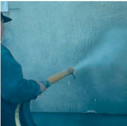
Bei oberflächlich sandenden bzw. kreidenden mineralischen Untergründen sowie bei tragfähigen Putzen mit unterschiedlichem Saugverhalten ist eine Grundierung mit Rajasil TG W (Tiefengrund W) erforderlich (Trockenzeit mind. 12 Stunden).
