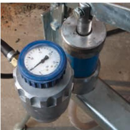
Der erforderliche Injektionsdruck von 3 – 5 bar wird über einen Zeitraum von 5 – 10 Minuten (in Abhängigkeit von den Mauerwerksbedingungen) gehalten. Anschließend wird das Verschlussstück geschlossen.
