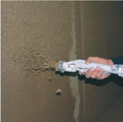
Auf die trockene Rajasil LS (Lehmschlämme) bzw. den ausreichend erhärteten Rajasil SPB (Spritzbewurf) wird Rajasil LP (Lehmputz) in entsprechender Schichtdicke aufgebracht. Der Auftrag erfolgt mit der Putzmaschine oder von Hand. Rajasil LP (Lehmputz grob) kann in einer Schichtdicke von 10 – 20 mm pro Lage und Rajasil LP (Lehmputz fein) von 5 – 10 mm aufgetragen werden. Unmittelbar nach dem Auftrag von Rajasil LP (Lehmputz) wird die Oberfläche mit der h-Kartätsche abgezogen.
