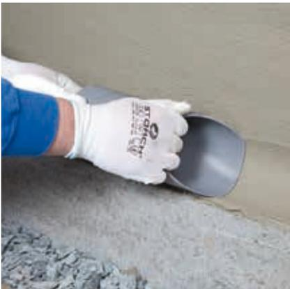
Innenecken und Wand-/Bodenanschlüsse werden als Hohlkehle ausgebildet und mit Rajasil SPP (Sperrputz) (Radius ca. 5 cm) hergestellt. Nicht gefaste Außenecken und Fundamentkanten werden gebrochen (anfasen).
