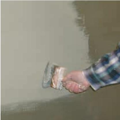
Auf den ausreichend erhärteten Rajasil SPP (Sperrputz) (Standzeit mind. 1 Tag pro mm Putzdicke) wird Rajasil DS FLEX (Dichtungsschlämme flexibel) in mindestens zwei Arbeitsgängen aufgebracht. Die Nassschichtdicke der Abdichtung beträgt mindestens 2,5 mm (= Trockenschichtdicke  $\geq$  2 mm). Der Auftrag kann z. B. durch Schlämmen mit dem Quast erfolgen. Rajasil DS FLEX (Dichtungsschlämme flexibel) kann, je nach Konsistenz, auch im Spachtel- oder Spritzverfahren aufgebracht werden.
