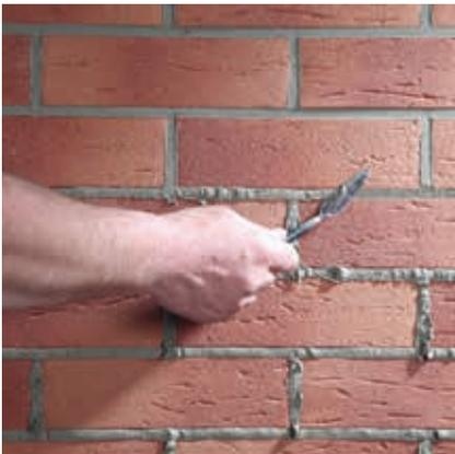
Fugen mit einer Tiefe größer als 2 cm müssen in mehreren Arbeitsgängen nass-in-feucht verfüllt werden. Die maximale Schichtdicke beträgt 2 cm. Tiefere, mit diesem Mörtel nicht vollständig zu verfüllende Fugen, sind z. B. mit Rajasil FM (Fugenmörtel) Kalkzement 0 - 2 bis zur maximalen Fugentiefe vorher auszufüttern.
