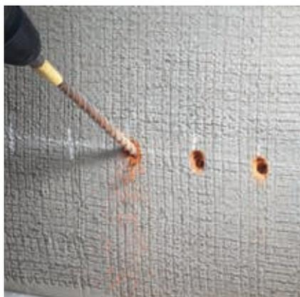
Der Bohrl Lochdurchmesser richtet sich nach den verwendeten Packern, wir empfehlen einen Durchmesser von 18 mm. Die Bohrlöcher werden in der gesamten Tiefe einheitlich im gleichen Durchmesser in einem Winkel von 10 ° bis 30 ° als Sacklöcher erstellt, so dass eine Restwanddicke von 5 cm bestehen bleibt (siehe Tabelle 2.4). Die Bohrungen sollten bei regelmäßigem Mauerwerk mindestens eine Lagerfuge schneiden. Bei Bruchsteinmauerwerk müssen möglichst viele Mauerfugen erfasst werden.
