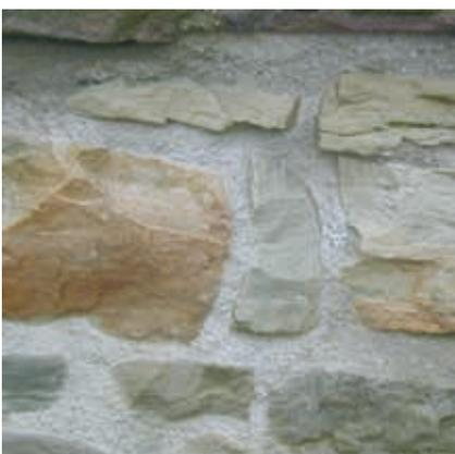
Durch Druckstrahlen (trocken oder nass frühestens am Tag danach) können die Steinköpfe freigelegt werden, dabei treten die Zuschläge im Fugennetz deutlich hervor.
