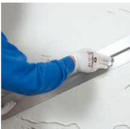
Über die gesamten Flächen erfolgt der Auftrag von Rajasil Sanierputz vorzugsweise Rajasil SP4 (Sanierputz SP4 mit HyTer-Technologie), in einer Mindestdicke von 2 cm (siehe 3.1 bis 3.3).
