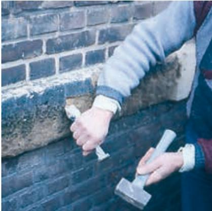
Die schadhafte Schicht ist bis auf den gesunden Naturwerkstein zu entfernen (Mindesttiefe 2 cm). Die Ränder müssen leicht hintergriffig ausgearbeitet werden. Glatte Oberflächen werden mit einem Spitz- oder Zahneisen aufgeraut.
