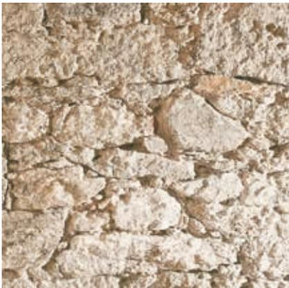
Das gesamte Mauerwerk einschließlich der Fugen wird gründlich von Staub, losen Teilen und Trennschichten befreit.
