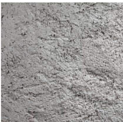
Bei mit Dichtungsschlämme verdämmtem Mauerwerk wird Rajasil DS FLEX (Dichtungsschlämme flexibel) nochmals satt aufgetragen und anschließend Rajasil SPB (Spritzbewurf) netzförmig in die noch frische Schlämme eingeworfen.
