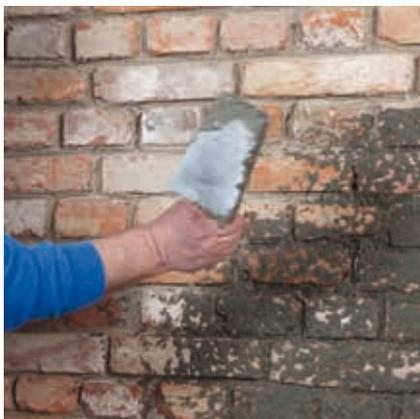
Wenn in größeren Bereichen glatte, wenig saugende Steine vorhanden sind, wird Rajasil SPB (Spritzbewurf) netzförmig als Haftbrücke aufgebracht (Standzeit mindestens 12 Stunden). Der Auftrag kann mit geeigneter Putzmaschine oder von Hand erfolgen.
