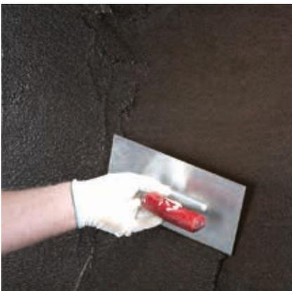
Auf den getrockneten Voranstrich wird Rajasil DB (Dickbeschichtung) bzw. Rajasil 2K DB (2K-Dickbeschichtung) in zwei Arbeitsgängen aufgebracht.
