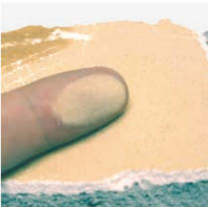
Putzausbesserungen im Bereich der freigelegten Hohlstellen und Fehlstellen mit einem Mörtel vornehmen, der nach dem Erhärten ähnliche Eigenschaften wie der Altputz aufweist (z. B. Rajasil KP (Kalkputz) oder Rajasil MLP (Mineralleichtputz). Bei größeren Flächen oder bei glatten, wenig saugenden Untergründen wird vorher eine Haftbrücke aus Rajasil SPB (Spritzbewurf) netzförmig aufgebracht.
