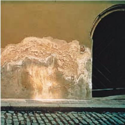
Der Altputz wird bis mindestens 80 cm über die Durchfeuchtungs- bzw. Ausblühungszone hinaus vollständig entfernt. Dabei wird eine gerade Begrenzungslinie zum verbleibenden Altputz angestrebt. Mürbe Fugen werden ca. 2 cm tief ausgekratzt.
