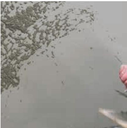
Ist eine hochwertige Nutzung der Kellerräume z. B. als Wohnraum vorgesehen, empfehlen wir eine feuchteegalierende Putzschicht mit Rajasil SP4 (Sanierputz SP4 mit HyTer-Technologie) oder Rajasil ULP (Ultraleichtputz). Zur Untergrundvorbereitung wird eine Haftbrücke aus Rajasil SPB (Spritzbewurf) netzförmig in die letzte Schicht der noch mattfeuchten Rajasil DS FLEX (Dichtungsschlämme flexibel) aufgebracht.
