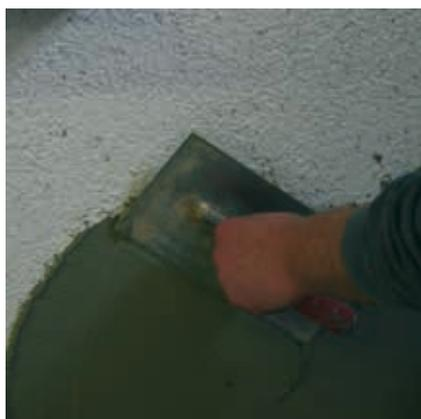
Rajasil RP (Renovierputz) wird in einer Dicke von ca. 5 mm aufgebracht. Die Strukturierung der Oberfläche kann z. B. mit Traufel, Kelle, Spachtel oder Bürste erfolgen. Es soll stets nass-in-nass gearbeitet werden, bei größeren Flächen muss auf jeder Gerüstlage mind. ein Mann arbeiten.
