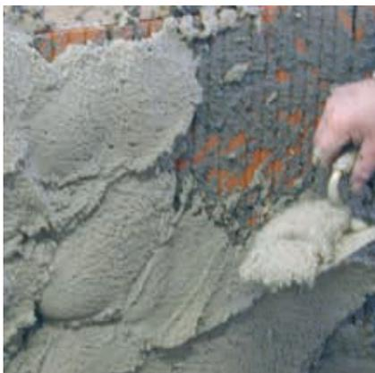
Anschließend erfolgt der Auftrag von Rajasil PGP (Porengrundputz SP2) in einer Mindestdicke von 10 mm, mit dem auch eventuelle Mauerwerksunebenheiten ausgeglichen werden können. Der Auftrag erfolgt von Hand oder mit der Putzmaschine. Es können alle üblichen Mischpumpenmaschinen eingesetzt werden. Je nach Maschinentyp kann ein Nachmischer erforderlich sein.
