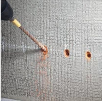
Der Bohrlochdurchmesser richtet sich nach den verwendeten Packern, wir empfehlen einen Durchmesser von 18 mm. Die Bohrlöcher werden in der gesamten Tiefe einheitlich im gleichen Durchmesser in einem Winkel von 10 ° bis 30 ° als Sacklöcher erstellt, so dass eine Restwanddicke von 5 cm bestehen bleibt (siehe Tabelle 2.4). Die Bohrungen sollten bei regelmäßigem Mauerwerk mindestens eine Lagerfuge schneiden. Bei Bruchsteinmauerwerk müssen möglichst viele Mauerfugen erfasst werden.
