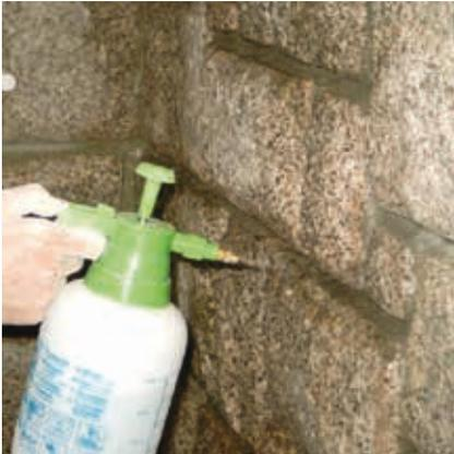
Loser und mürber Fugenmörtel wird bis auf eine Tiefe von ca. 1,0 cm entfernt. Die Fugen werden von Staub und losen Teilen gründlich gereinigt. Anschließend werden die Fugenflanken mattfeucht vorgenässt.
