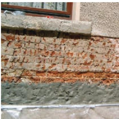
Der Altputz wird bis mindestens 80 cm über den feuchte- und salzbelasteten Bereich entfernt, mürbe Fugen werden ca. 2 cm tief ausgekratzt. Dabei wird eine durchgehende gerade Begrenzungslinie zum verbleibenden Altputz angestrebt. Das Mauerwerk sowie die Fugen werden anschließend von Staub und losen Teilen gereinigt.
