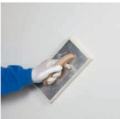
Für geeignete Trocknungsbedingungen muss gesorgt werden (z. B. in schlecht belüfteten Räumen Raumtrockner aufstellen). Ein zu schnelles Aufheizen der Räume muss vermieden werden.
