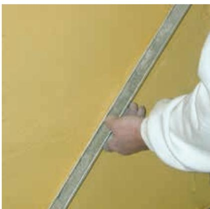
Die Oberfläche wird während des Ansteifens lot- und fluchtrecht bzw. dem Mauerwerk folgend abgezogen. Anschließend kann die Oberfläche z. B. durch Filzen strukturiert werden (die Übergangsbereiche Sanierputz/vorhandener Putz müssen zuerst bearbeitet werden).
