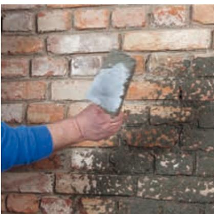
Auf den entsprechend vorbereiteten Untergrund wird Rajasil SPB (Spritzbewurf) netzförmig als Haftbrücke aufgebracht (Standzeit mindestens 12 Stunden). Der Rajasil SPB (Spritzbewurf) darf den Untergrund nur zu 50 % bedecken. Der Auftrag erfolgt von Hand.
