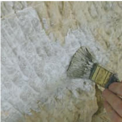
Auf den angefeuchteten Untergrund wird Rajasil STRM (Steinrestauriermörtel spezial schlämmfähig) z. B. mit dem Pinsel auf den vorbereiteten Stein aufgeschlämt. Pro Arbeitsgang kann eine Auftragsdicke von 3 – 5 mm erreicht werden. Die Mindestdicke des Mörtels sollte 3 mm betragen. Im Randbereich kann der Mörtel gegen „Null“ auslaufend angebracht werden.
