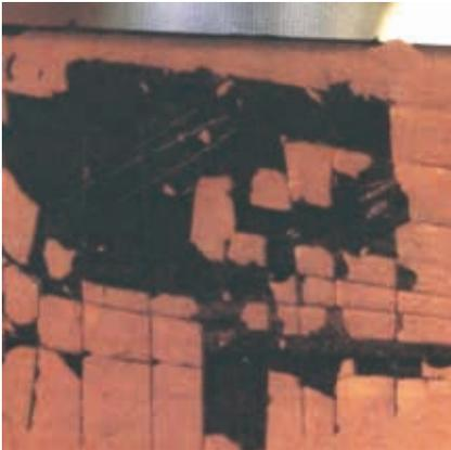
Mineralische Anstriche auf ausreichende Haftung und Kreidung prüfen. Haftung bestehender Beschichtungen mittels Gitterschnitt nach DIN 53 151 an verschiedenen Stellen der Fassade prüfen.
