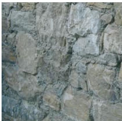
Nach dem Entfernen des Altputzes wird das Mauerwerk gründlich von Staub und losen Teilen gereinigt. Mürbe Fugen werden ca. 2 cm tief ausgekratzt.
