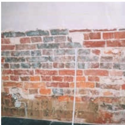
Es wird eine gerade Begrenzungslinie zum verbleibenden Altputz angestrebt. Mürbe Fugen werden ca. 2 cm tief ausgekratzt.
