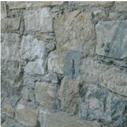
Das Mauerwerk sowie die Fugen werden von Staub und losen Teilen gründlich gereinigt. Der anfallende Schutt muss abseits gelagert werden und wird täglich entfernt.
