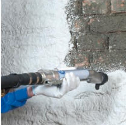
Der Auftrag von Rajasil SP3 (Sanierputz SP3) bzw. Rajasil SP4 (Sanierputz SP4 mit HyTer-Technologie) erfolgt mit der Maschine oder von Hand in gleichmäßiger Putzdicke.
