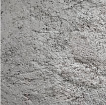
Bei mit Dichtungsschlämme versehenen Mauerwerk wird Rajasil DS FLEX (Dichtungsschlämme flexibel) nochmals satt aufgetragen und anschließend Rajasil SPB (Spritzbewurf) netzförmig in die noch frische Schlämme eingeworfen.
