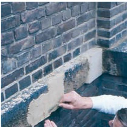
Der Mörtel wird mit Spachtel oder Streicheisen hohlraumfrei auf den angefeuchteten Untergrund aufgebracht und gut angedrückt. Um den richtigen Grad der Anfeuchtung für den Naturstein festzustellen, ist ein Vorversuch erforderlich (zu trockener Untergrund bewirkt ein Verdursten und zu nasser Untergrund verhindert ein ausreichendes Stehvermögen des Mörtels).
