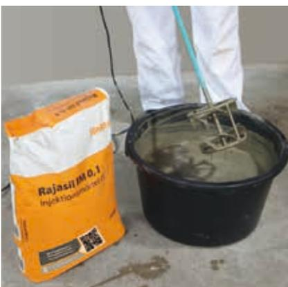
Zum Verschließen der Bohrlöcher kann Rajasil IM 0,1 (Injektionsmörtel 01) durch die Packer injiziert werden.
