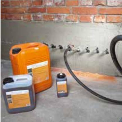
Über die angebrachten Packer wird Rajasil NIG mittels Handhebelpresse oder einer elektrisch betriebenen Injektionspumpe eingebracht.
