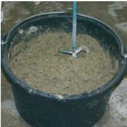
Unter Vorgabe der notwendigen Wassermenge wird der Mörtel in einem sauberen Mörtelkübel mit dem Motorquirl oder im Zwangsmischer knollenfrei angemischt. Im Regelfall wird eine erdfeuchte Konsistenz eingestellt.
