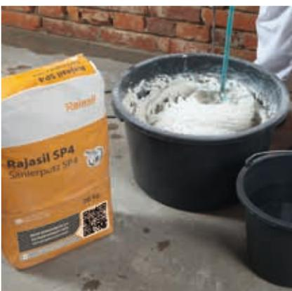
Handverarbeitung: Unter Vorgabe der notwendigen Wassermenge wird der Trockenmörtel in einem sauberen Mörtelkübel mit dem Motorquirl knollenfrei angemischt.
