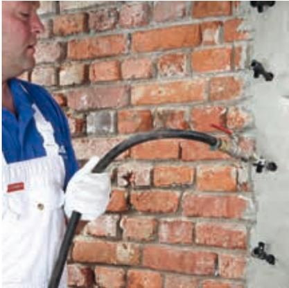
Das Injizieren erfolgt von unten nach oben. Es wird so lange injiziert, bis aus dem darüber liegenden Packer das Material herausläuft. Der Injektionsdruck beträgt max. 7 bar. Nach der Injektion werden die Verschlussstücke abgeschraubt und gereinigt. Aus dem Mauerwerk hervorstehende Lamellenschlagpacker (Einwegpacker) werden mit dem Winkelschleifer oder einem Bolzenschneider abgeschnitten.
