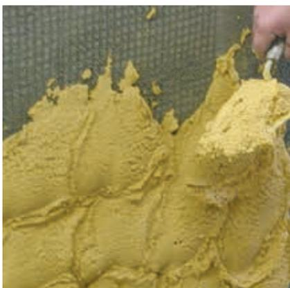
Nach einer Standzeit von mind. 1 Tag/mm Putzdicke wird Rajasil SP2 (Sanierputz SP2) im gewünschten Farbton in einer Dicke von mindestens 15 mm (bei hoher Salzbelastung in einer Dicke von mindestens 20 mm) maschinell oder von Hand aufgebracht.
