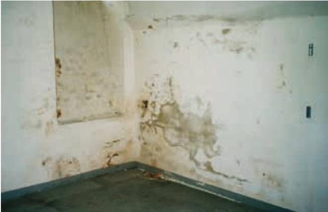
**Abb. 1:** Kellerwände vor der Sanierung
