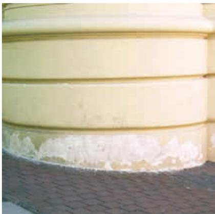
Der Altputz wird bis mindestens 80 cm über die Durchfeuchtungs- bzw. Ausblühungszone hinaus vollständig entfernt.
