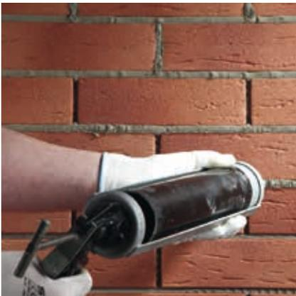
Rajasil FM SPF (Fugenmörtel spritzfähig) kann manuell mit einer speziellen Fugenmörtelspritzpistole direkt in die mattfeuchte Fuge eingebracht werden. Kunststoffkartuschen verwenden (Metallkartuschen sind auf Grund der Anlösung durch die Alkalität des Mörtels ungeeignet).
