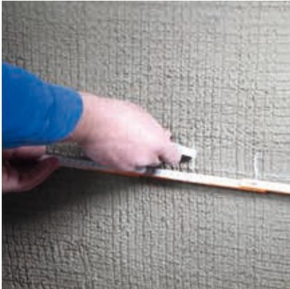
Nach dem Festlegen der Injektionsebene (diese liegt in der Regel ca. 30 cm oberhalb des erdberührten Bereichs, siehe 2.5) werden in einem Abstand von maximal 10 cm die Bohrlochabstände markiert. Eine einreihige Bohrlochanordnung ist üblicherweise ausreichend.
