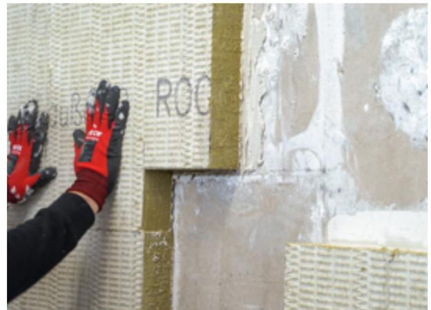
Offene Stoßfugen sind zu vermeiden. Unvermeidbare Spalten müssen mit gleichwertigem Dämmstoff geschlossen werden. Dabei dürfen Fugen bis 5 mm Breite auch bei Steinwolle-Dämmplatten mit PU-Schaum B1 geschlossen werden. Größere Fugen sind mit zugeschnittenen Dämmstoffstreifen zu verschließen. Eventuell vorhandene Plattenversätze müssen unbedingt verschliffen werden, um Putzdrückensprünge in der Armierungsschicht zu vermeiden.
