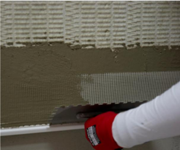
Das Sockelprofil weist beim Einbau auf Außenwandflächen von beheizten Räumen eine geringe Wärmebrückenwirkung auf. Dieser Sachverhalt gewinnt mit zunehmender Dämmplattendicke an Bedeutung und sollte z. B. bei Passivhäusern berücksichtigt werden.
