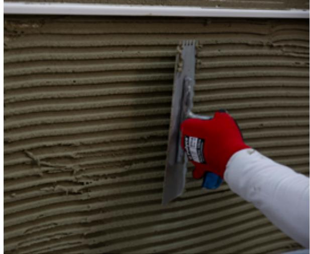
Kommen dicklagige Oberputze oder keramische Beläge zur Anwendung, kann zusätzlich das HECK Aufsteckprofil (wahlweise in Aluminium oder Edelstahl, passend zur Sockelschiene, Ausladung 6 mm, mit Gewebe) vor Ansetzen der Dämmplatten auf die Sockelprofile aufgesteckt werden. Es ist darauf zu achten, dass die Stöße des Aufsteckprofils versetzt (min. 15 cm) zu denen des Sockelprofils zu verlegen sind.
