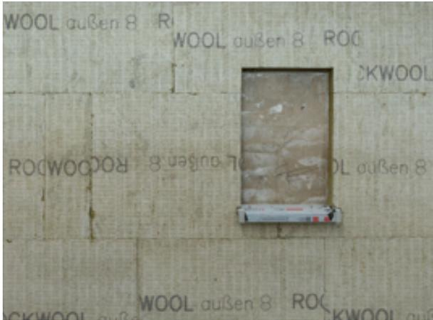
Im Eckbereich der Fensteröffnungen werden die Dämmplatten „ausgeklinkt“ (oben und auch unten). L-Schnitt oder T-Fuge sind zulässig. Bei Fensterleibungen üblicher Tiefe ragen die Fassadenplatten in die Gebäudeöffnung hinein, so dass der Dämmstoffstreifen für die Leibung wärmebrückenfrei eingepasst werden kann.
