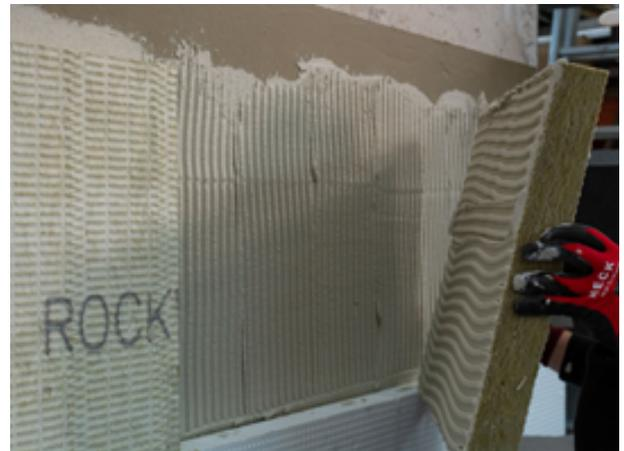
Die Dämmplatten werden lot- und fluchtgerecht im Verband verlegt. Kreuzfugen sind nicht zulässig. Es ist zu beachten, dass kein Klebemörtel auf die Stirnseiten der Dämmstoffplatten gelangt. Um die Plattenoberfläche nicht zu beschädigen, wird zum Anpressen ein flächiges Werkzeug (Holzreibebrett, Schleifbrett o.ä.) empfohlen.
