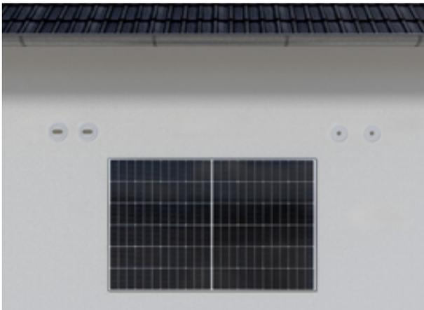
Spezialmodule, die komplett in das WDVS integriert werden, gewährleisten eine lückenlose Dämmung und verhindern Wärmeverluste, während sie gleichzeitig modernen Anforderungen gerecht werden. Solche Anforderungen können Nistkästen sein, die nahtlos in die Fassadendämmung eingebettet werden. Weitere Anwendungen können z. B. Klingelanlagen, Photovoltaik-Systeme (PV-Module), Wallboxen für E-Fahrzeuge und spezielle Wanddurchführungen sein.
