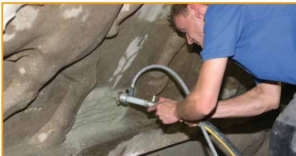
Aufbringen einer Salzkompressen per Maschinenteknik
