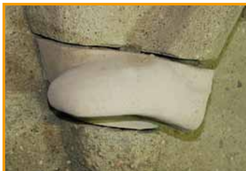
Die Schuhe der Reiter mussten vollständig entfernt und neu gegossen und verankert werden
