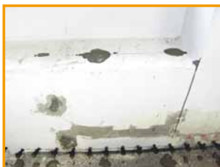
Austretender Injektionsmörtel. Hohlräume im Mauerwerk sind verfüllt.
