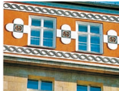
Art-deco-Fries Feuerbach-Straße in Leipzig Schwerpunkt: farbige Rajasil Kratzputze für Sgraffito-Technik
