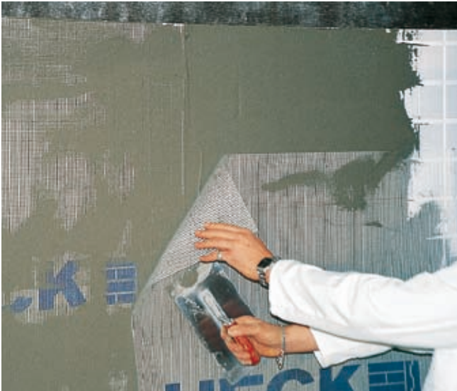
① Appliquer HECK K + A sur le panneau isolant.
