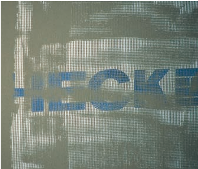
③ Enduire de nouveau entièrement de HECK K + A.
