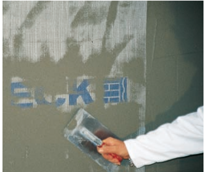
② Enrober HECK AGG FINE (tissu de renforcement fin) dans la masse fraîche.
