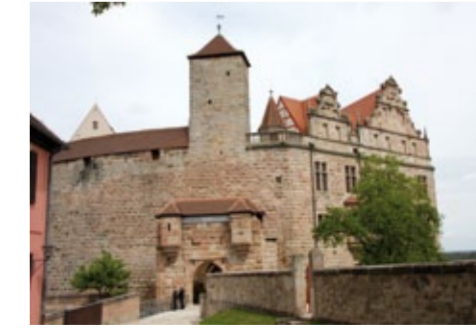
Das Burgschloss Cadolzburg wird gegenwärtig wieder aufgebaut und saniert, nachdem es in Folge des zweiten Weltkriegs jahrzehntlang in Trümmern lag.
