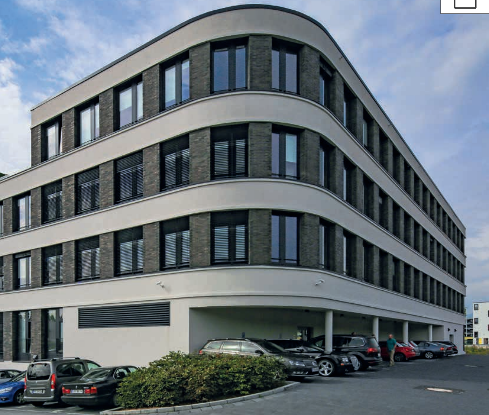
Bad Homburg, Verwaltungsgebäude, 2.500 m 2 WDVS mit 500 m 2 Klinker und 500 m Dekorelementen u. Stuckprofilen
