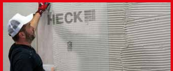
Armierungsmörtel auftragen, Armierungsgewebe einbetten
