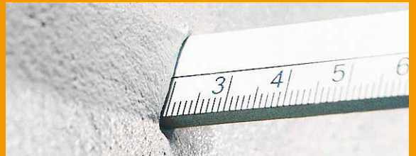
Putzdicke: Die Mindestsanierputzdicke beträgt 20 mm und die maximale Gesamtsanierputzdicke 40 mm.
