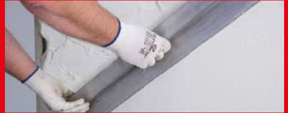
Oberfläche abziehen
