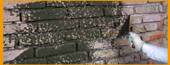
Haftbrücke: Vorbereitung des Untergrunds und Anbringen des Spritzbewurfs Rajasil SPB als Haftbrücke.
