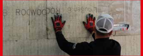
Dämmplatte andrücken und einschwimmen
