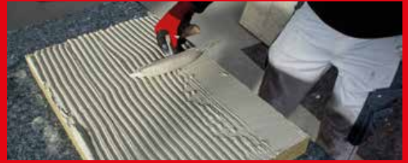
Kleber auf Dämmplatte auftragen
