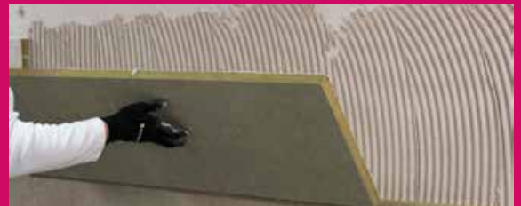
Dämmplatte andrücken und einschwimmen
