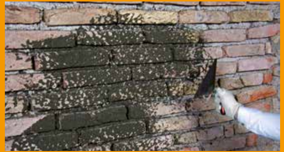
Haftbrücke: Vorbereitung des Untergrunds und Anbringen des Spritzbewurfs Rajasil SPB als Haftbrücke.
