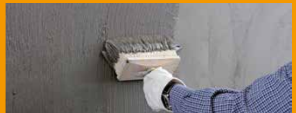
Dichtungsschlämme: Die Dichtungsschlämme HECK DS FLEX LIGHT sorgt für die zuverlässige Abdichtung.
