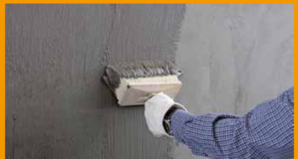
Dichtungsschlämme: Die Dichtungsschlämme HECK DS FLEX LIGHT sorgt für die zuverlässige Abdichtung.
