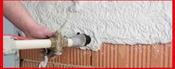
Dämmputz maschinell aufbringen
