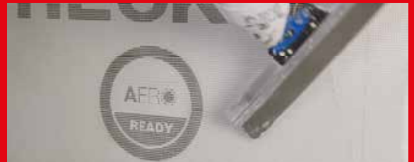
Einbetten des Armierungsgewebes
