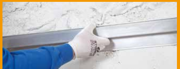
Abziehen: Die Oberfläche wird während des Anstehens lot- und fluchrecht bzw. dem Mauerwerk folgend abgezogen.
