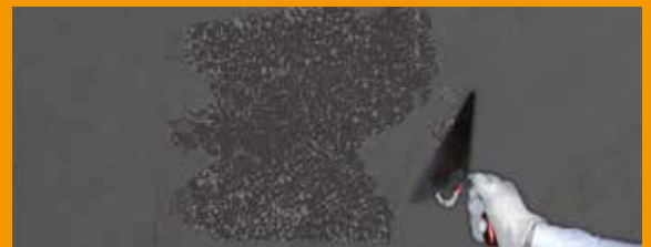
Haftbrücke: Anbringen des Spritzbewurfs Rajasil SPB als Haftbrücke nass in feucht.
