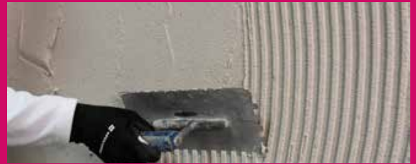
Kleber auf Untergrund auftragen
