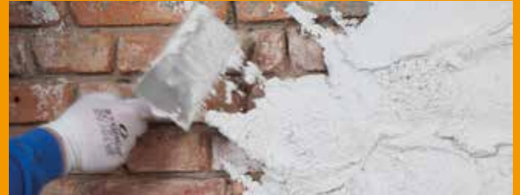
Auftragen: Sanierputz SP5 mit der Maschine oder von Hand in gleichmäßiger Putzdicke (10 mm Schritte) aufbringen.
