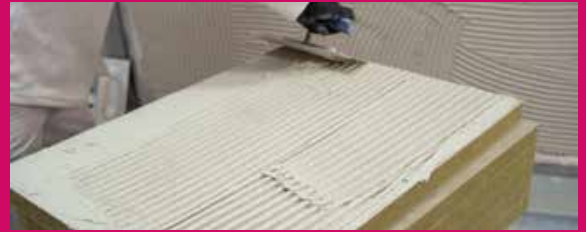
Kleber auf Dämmplatte auftragen
