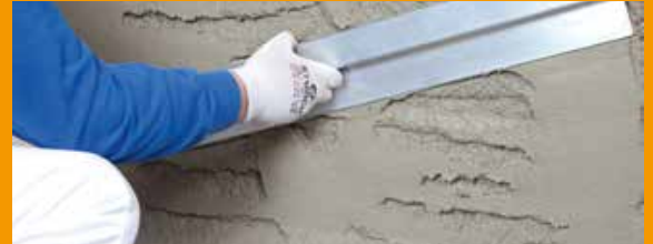
Sperrputz: Der Sperrputz Rajasil SPP schafft einen geeigneten Untergrund und egalisiert die Wandoberfläche.
