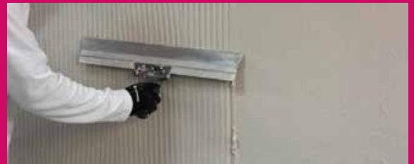
Armierungsmörtel auftragen, Armierungsgewebe einbetten
